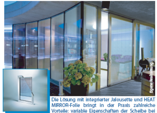
Die Lösung mit integrierter Jalousie und HEAT MIRROR-Folie bringt in der Praxis zahlreiche Vorteile: variable Eigenschaften der Scheibe bei jedem Wetter, wartungsfreie Ausführung, rahmenlose Verglasung, geringes Gewicht des Schiebeflügels, maximaler Schutz der Privatsphäre, minimale Wärmeverluste. (eigene Realisierung, Einfamilienhaus Moravany, 2012)
