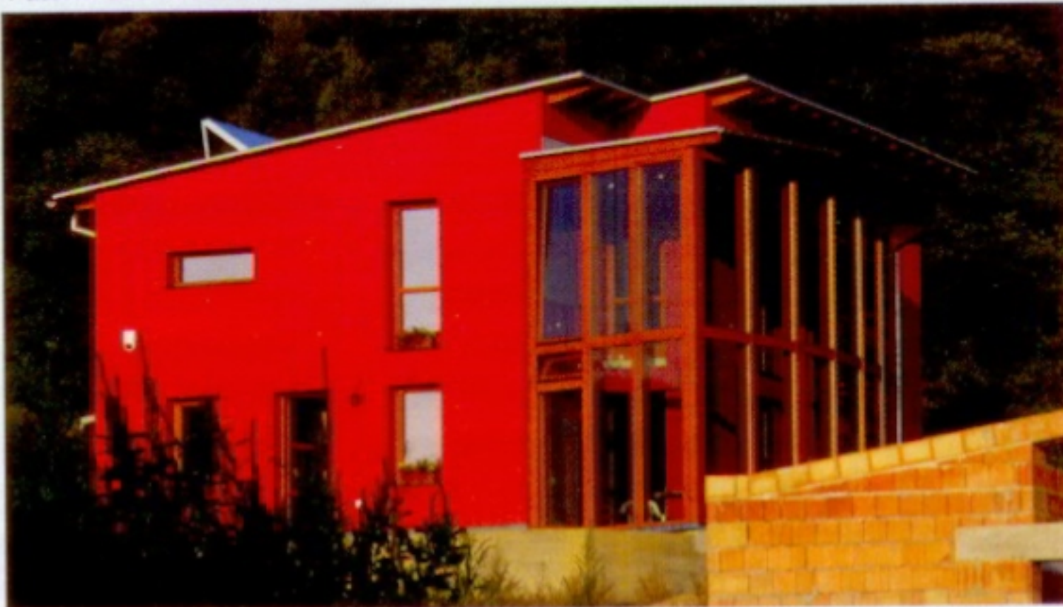
Pasivní dům se zasklením HEAT MIRROR® v Brně Kníničkách
