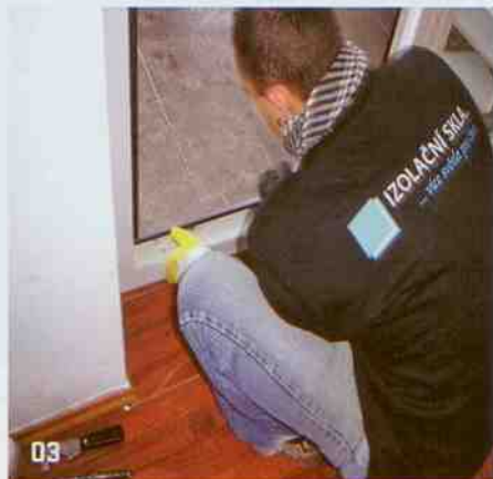
03 > Vyčištění zasklivací drážky v profilu
