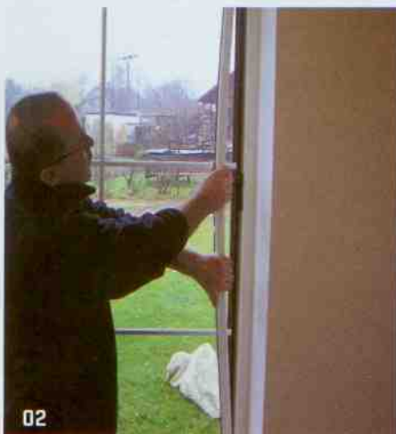
02 > Uvolnění a vyjmutí fixačních zasklivacích lišt osazených z interiéru
