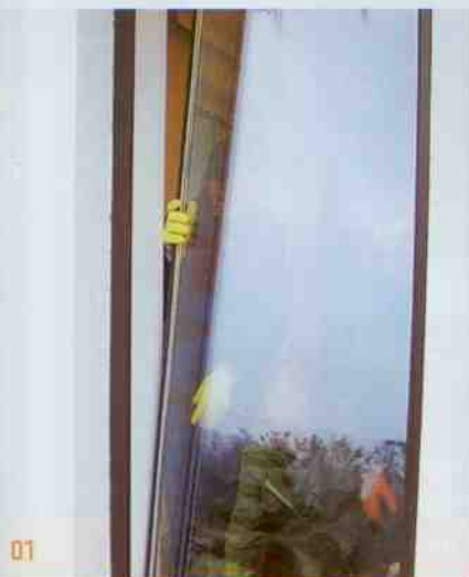
01 > Příprava distančních podložek a osazení nového izolačního skla
