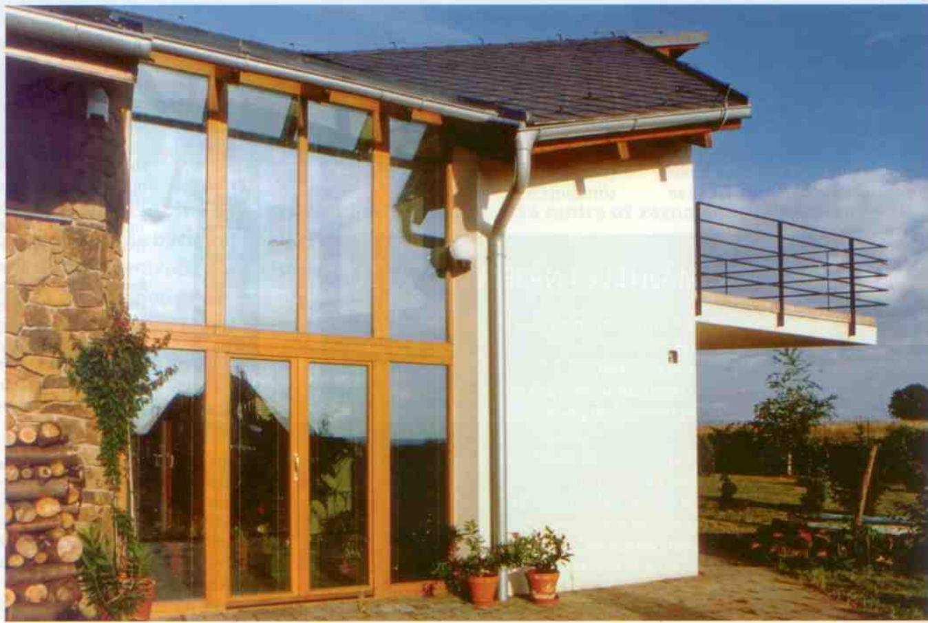
a montovaných oken, a to z jednoduchého důvodu. Většina výrobců oken udává součinitel prostupu tepla použitým zasklením  $U_g = 1,1 \text{ W/m}^2\text{K}$ , této hodnoty však skleněná výplň dosahuje pouze ve svém středu. Izolační vlastnosti se směrem k okrajům zhoršují, takže výsledný součinitel  $U_w$  se pohybuje v rozmezí 1,3 až 1,7  $\text{W/m}^2\text{K}$ .
