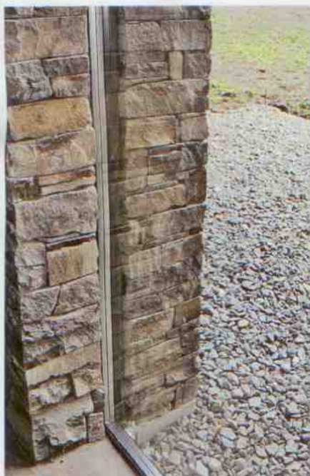
Bezrámové zasklení umožní opticky zajímavý efekt: sklo roste přímo z kamenné stěny
