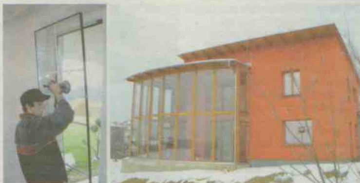
ÚSPORA. Přesklení izolačním sklem je rychlé a čisté. Foto: Izolační skla, a.s. (3x)
