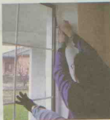
2. Uvolnění distančních podložek vyme- zujících polohu původního skla.
