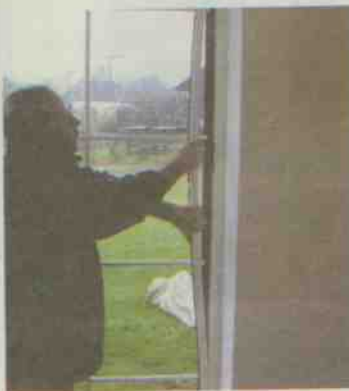
1. Uvolnění a vyjmutí fixačních zaskliva- vacích lišt osazených z interiéru.
