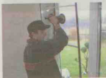
3. Vyjmutí původního skla.
